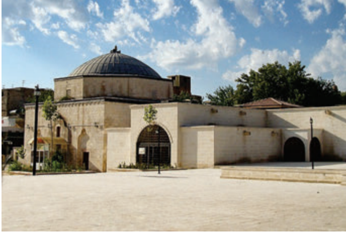
4) Eski Mevlevihane restorasyon sonrası / 2007 (Fotoğraf: S. Sabri Kürkçüoğlu)
